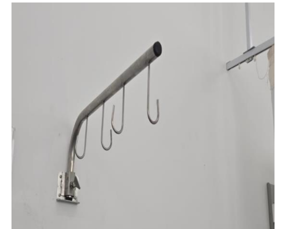
Instalação de suportes de soro
