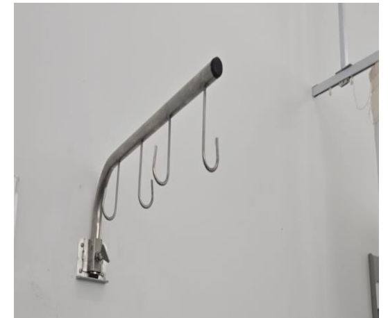
Instalação de suportes de soro
