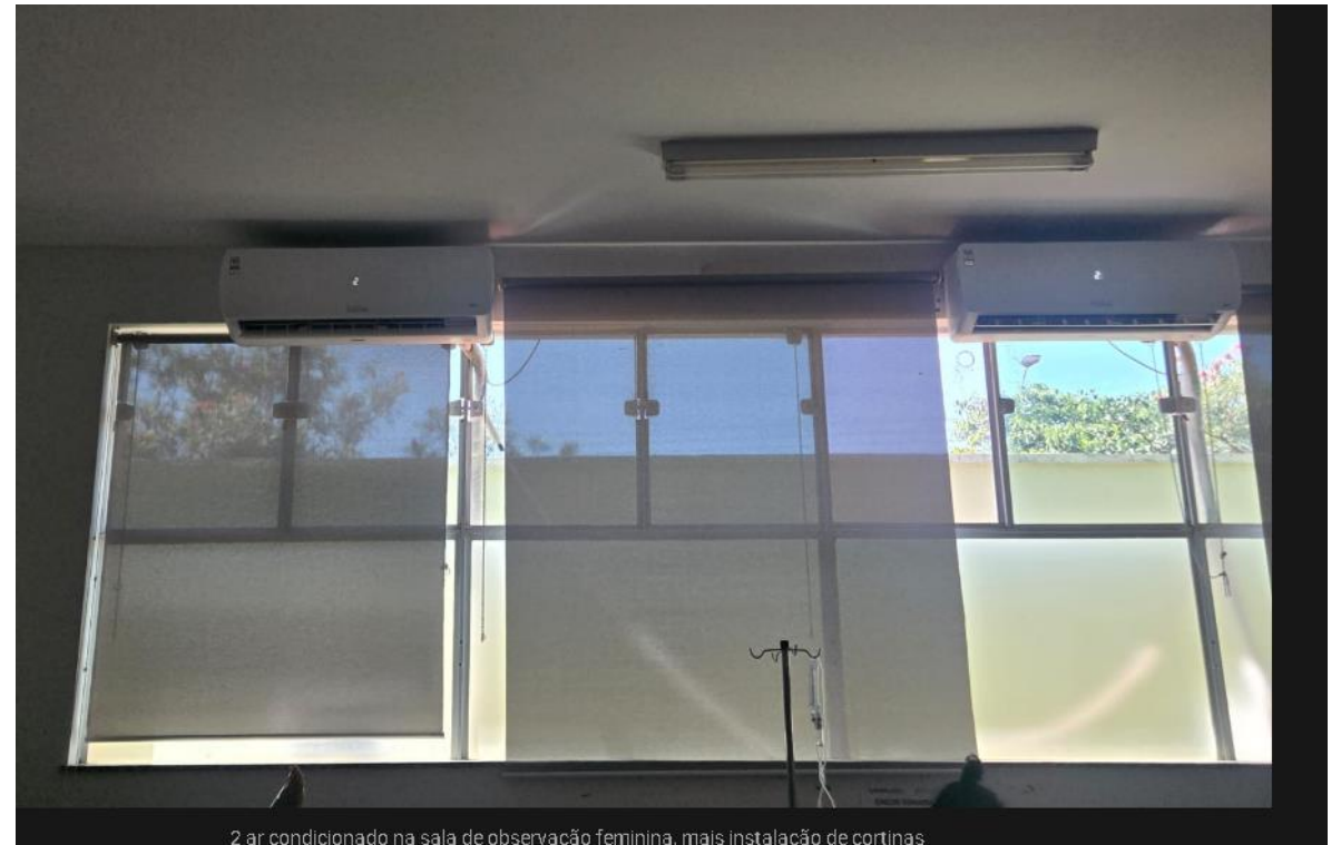
2 ar condicionado na sala de observação feminina, mais instalação de cortinas
